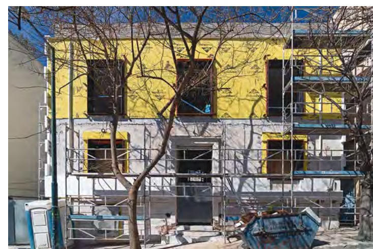
ΠΡΟΣΩΠΗ ΤΗΣ ΚΑΤΟΙΚΙΑΣ ΥΠΟ ΚΑΤΑΣΚΕΥΗ. ΔΙΑΚΡΙΝΕΤΑΙ Η ΠΡΟΣΘΗΚΗ ΤΟΥ ΟΡΟΦΟΥ.
