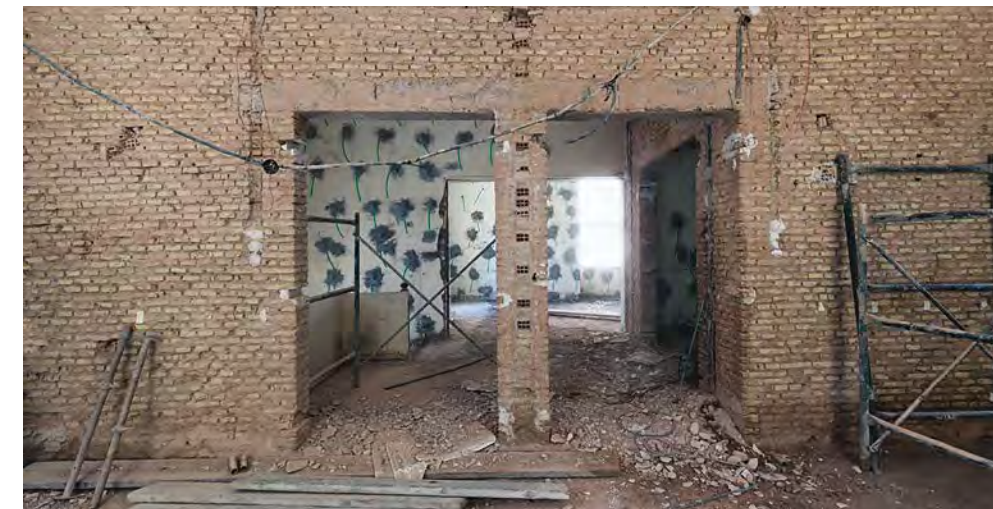
ΥΠΑΡΧΟΥΣΑ ΕΣΩΤΕΡΙΚΗ ΤΟΙΧΟΠΟΙΙΑ ΟΠΤΟΠΛΙΝΘΟΔΟΜΗΣ ΠΡΟΣ ΕΝΙΣΧΥΣΗ.
