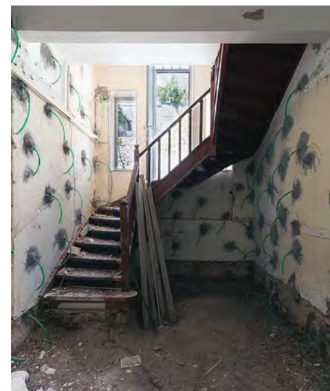
ΕΝΕΜΑΤΑ ΥΠΑΡΧΟΥΣΑΣ ΛΙΘΟΔΟΜΗΣ ΗΜΙΥΠΟΓΕΙΟΥ ΚΑΙ Η ΠΡΟΫΠΑΡΧΟΥΣΑ ΞΥΛΙΝΗ ΣΚΑΛΑ, ΠΟΥ ΑΝΤΙΚΑΤΑΣΤΑΘΗΚΕ.
